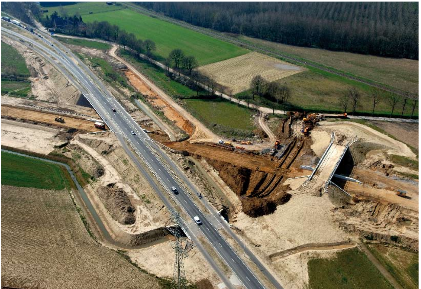
Aanleg A73-Zuid en Viaduct Leygraaf/ecoduct Schinheuwel, maart 2007 Foto: Peter Wijnands
